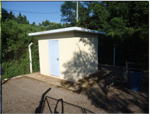
FOTO 02 – Estação de Tratamento
