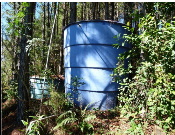
FOTO 05 – Reservatório Zona Rural
