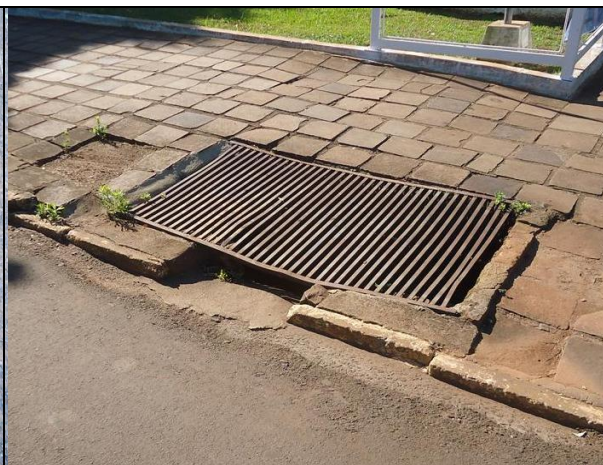
FOTO 04 – Boca de Lobo
