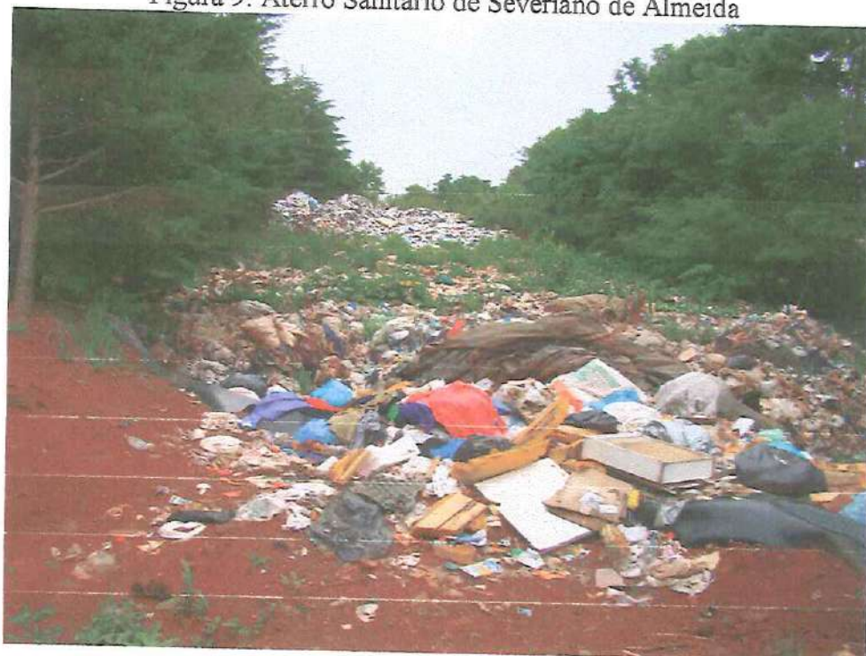
Figura 9: Aterro Sanitário de Severiano de Almeida
