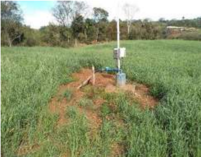
Figura 53: Vista geral do Poço tubular P1, alocado no entorno de uma área agrícola
