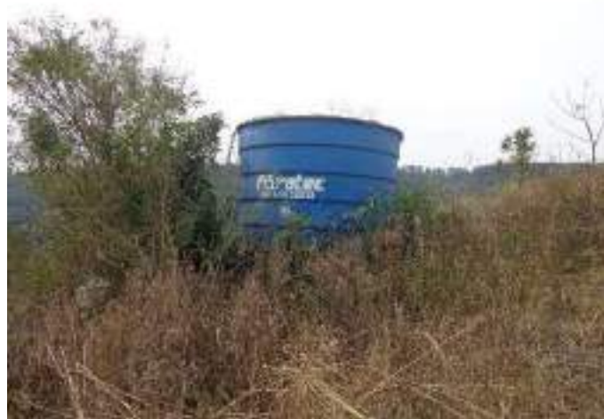
Figura 148: Vista geral do Reservatório R16, alocado próximo a uma área de produção agrícola
