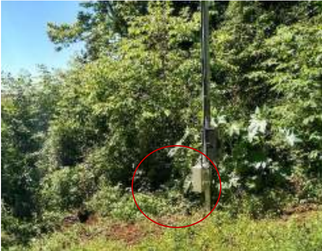
Figura 169: Vista geral do Poço tubular P 21, próximo à um fragmento florestal
