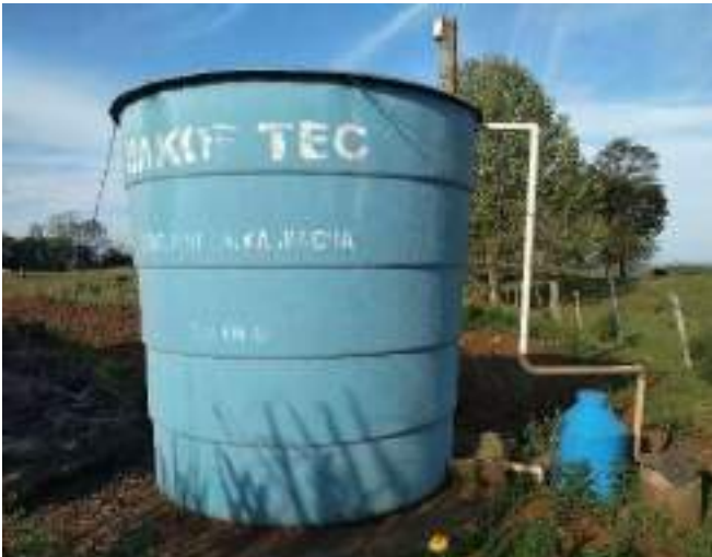
Figura 176: Vista geral do Reservatório R22, com estrutura para a cloração da água
