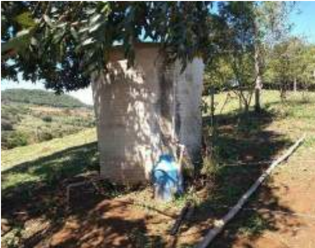
Figura 130: Vista geral do Reservatório R13, com cercamento
