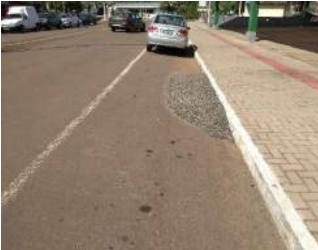
Figura 237: Configuração de rampa que impede a livre circulação da água pluvial pela sarjeta
