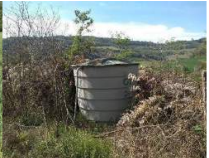
Figura 70: Reservatório R3, sem a presença de estrutura de cloração
