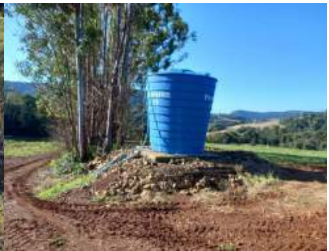
Figura 194: Vista geral do Reservatório R25
