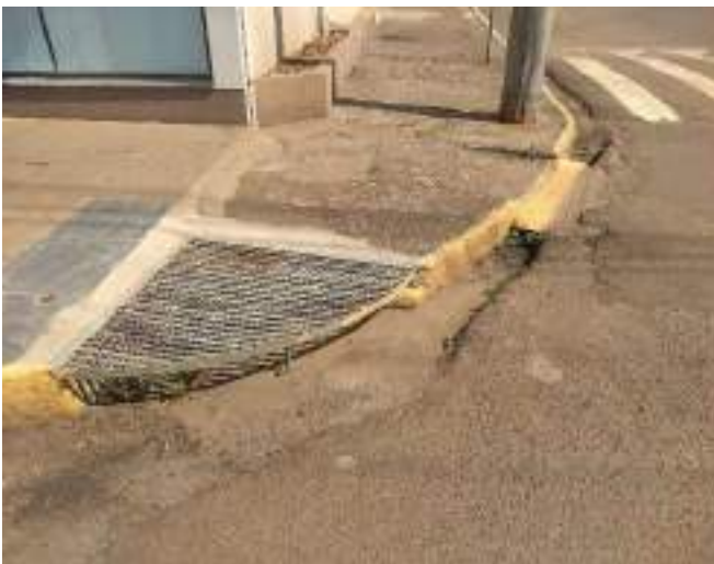
Figura 231: Infraestrutura de urbanização das vias públicas de Severiano de Almeida, com calçada, pavimentação, sarjetas e bocas de lobo
