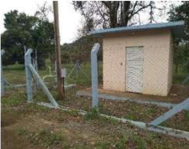
Figura 48: Vista geral do Poço tubular PC4, com controle de acesso e cercamento
