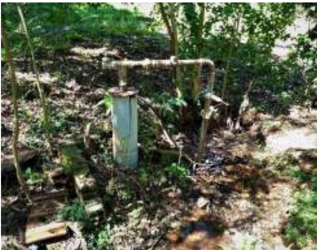
Figura 128: Vista geral do Poço tubular P13, com presença de afloramento de água
