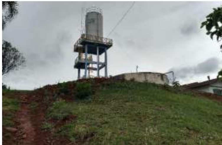
Figura 51: Vista dos reservatórios Rcs1 e Rcs2
