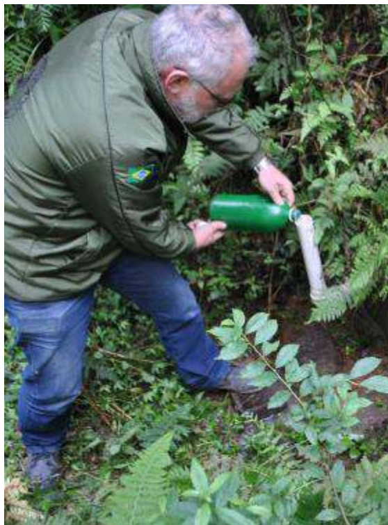
Figura 215: Tubo auxiliar para a cloração e desinfecção de fontes drenadas 16
