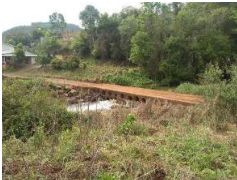
Figura 244: Ponte construída sobre o Lajeado Tigre, obra de melhoria para evitar a ocorrência de alagamentos na região
