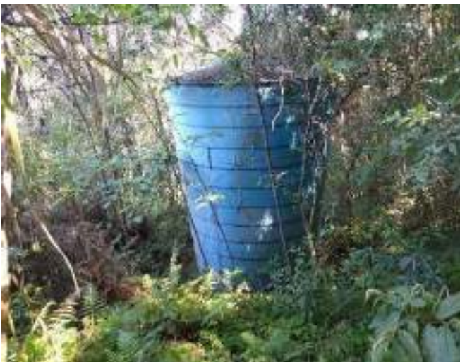
Figura 125: Vista geral do Reservatório R12, no interior de um fragmento florestal
