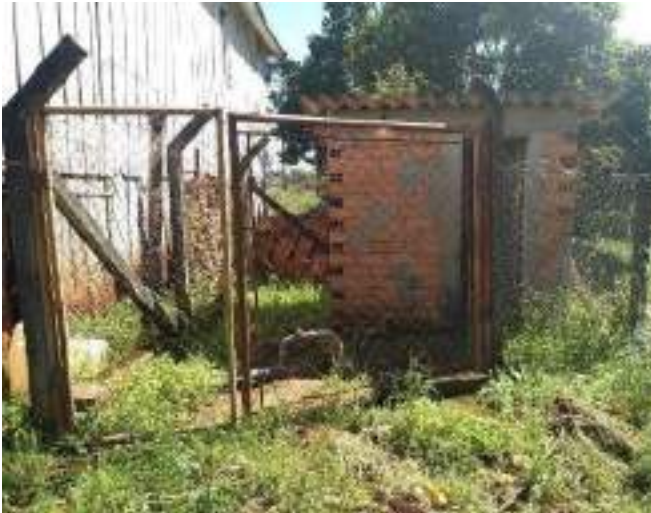
Figura 101: Vista geral do Poço tubular P7, com cercamento e controle de acesso
