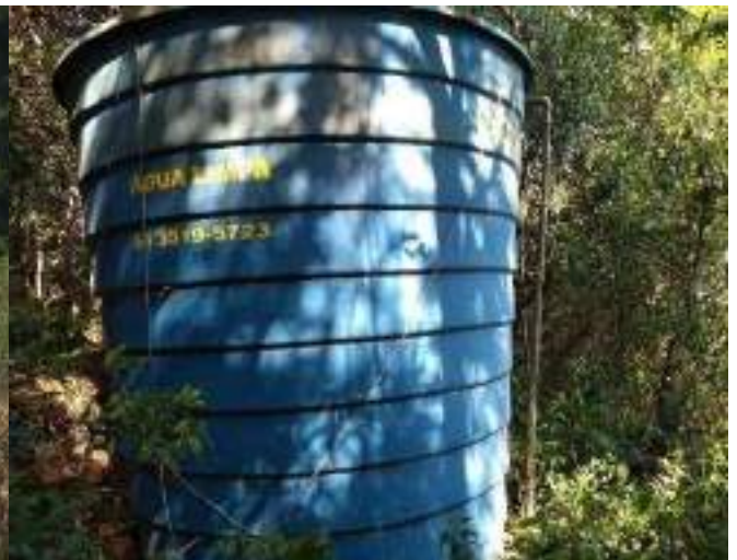
Figura 142: Reservatório R15, em meio a um fragmento florestal
