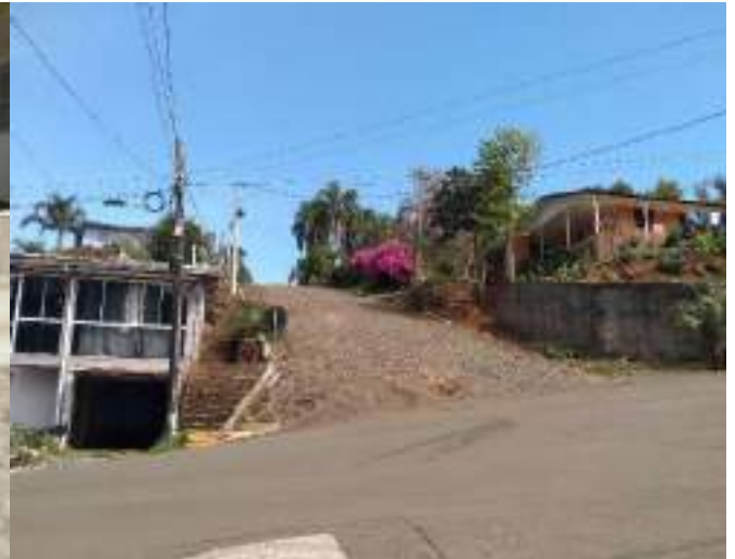
Figura 234: Arruamentos com pavimentação asfáltica e de paralelepípedos de basalto
