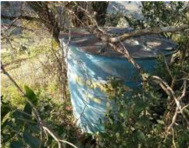
Figura 108: Vista geral do Reservatório R8, próximo à área agrícola
