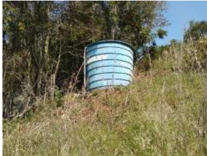
Figura 204: Vista geral do Reservatório R27, próximo a uma área agrícola
