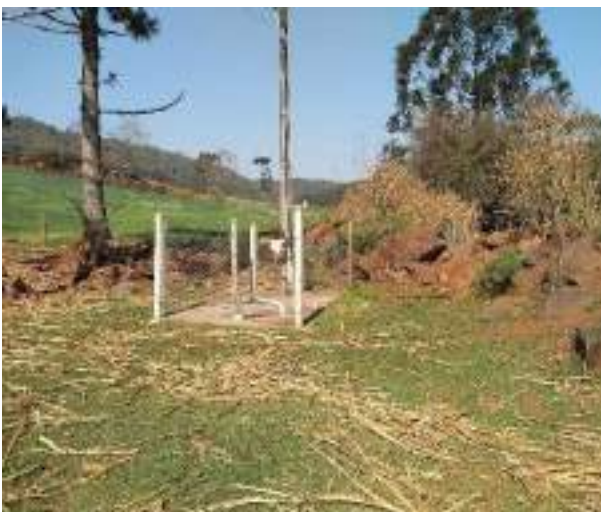
Figura 206: Vista geral do Poço tubular P28, com cercamento e controle de acesso
