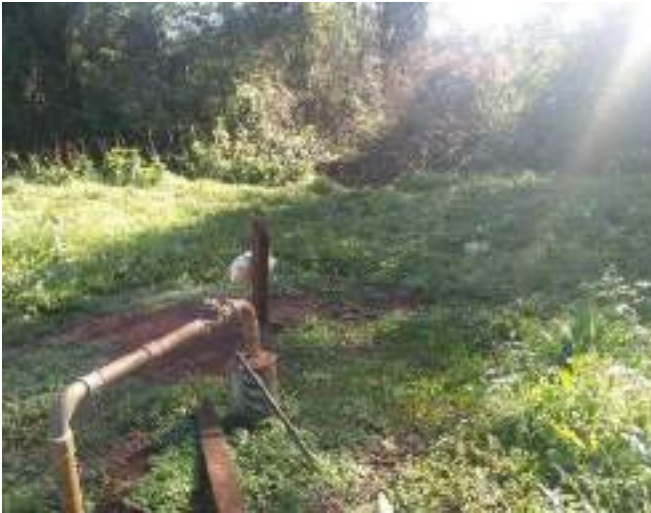
Figura 174: Vista geral do Poço tubular P22, alocado em uma área de criação de bovinos
