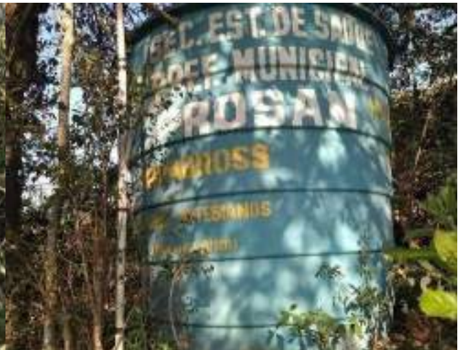
Figura 109: Reservatório R8, sem a presença de estrutura de cloração
