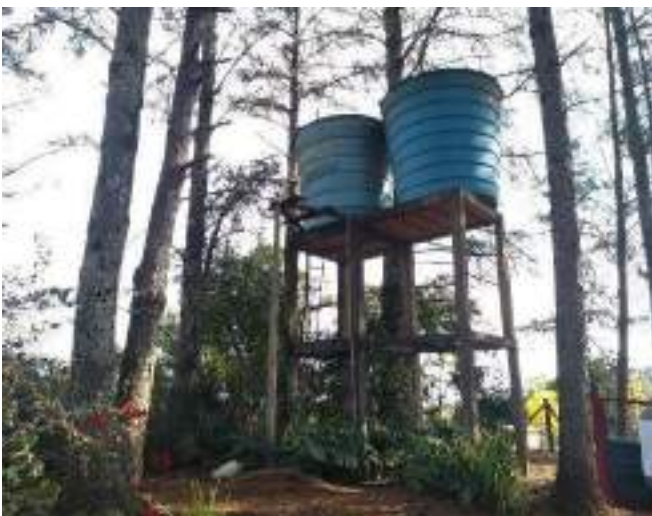
Figura 84: Vista geral do Reservatório R6, sobre estrutura elevada
