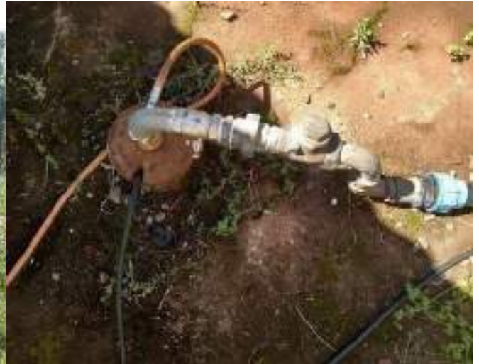
Figura 102: Poço tubular P7, com laje de proteção
