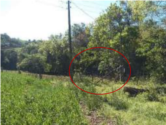
Figura 118: Vista geral do Poço tubular P11, no entorno de uma área agrícola
