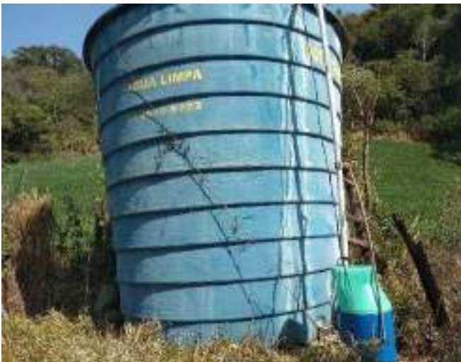
Figura 141: Reservatório recalque Rq15, com estrutura para a cloração da água
