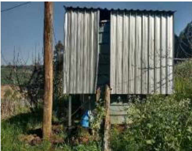
Figura 74: Vista geral do Reservatório R4, com estrutura de cercamento
