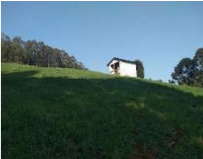
Figura 79: Vista geral do Reservatório R5, alocado em uma área agrícola
