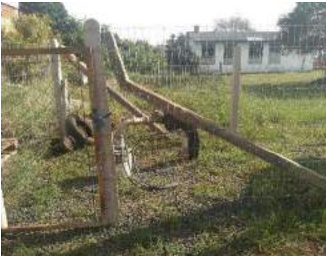
Figura 82: Vista geral do Poço tubular P6, com cercamento e controle de acesso
