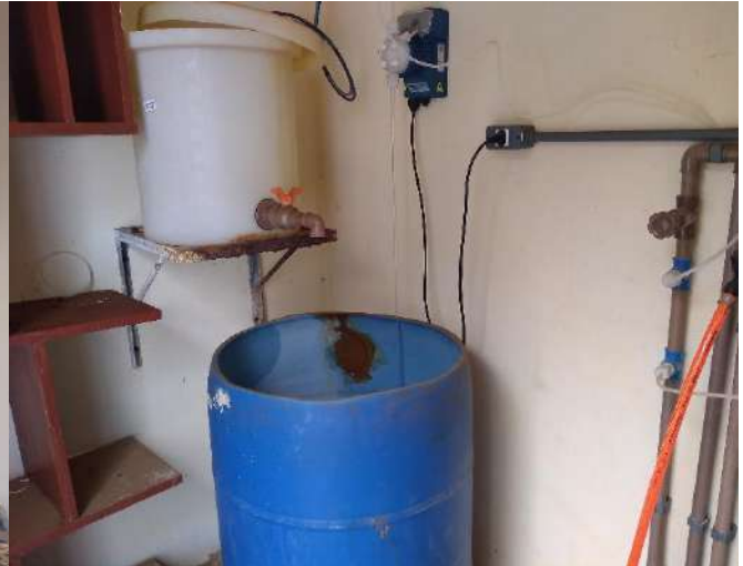
Figura 47: Sistema de armazenamento e bombeamento das soluções de tratamento
