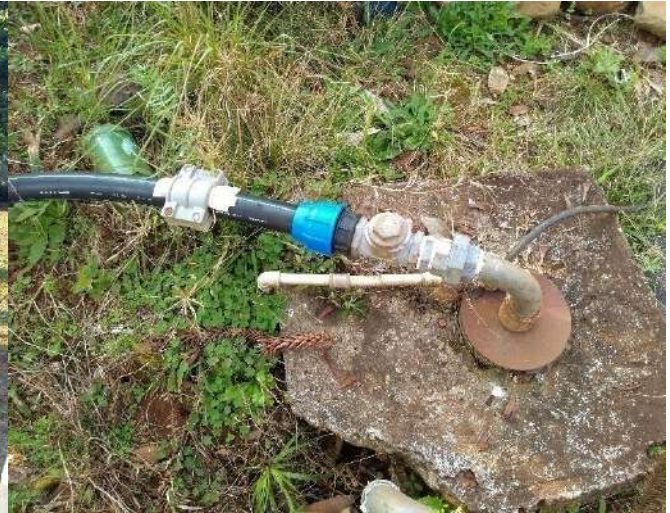
Figura 156: Poço tubular P18, com a presença de laje de proteção
