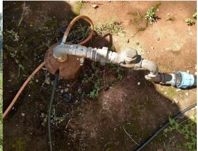
Figura 102: Poço tubular P7, com laje de proteção
