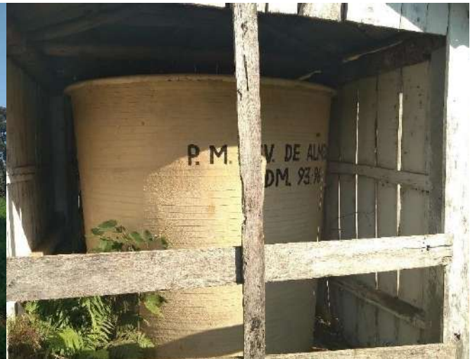
Figura 80: Reservatório R5, com instalação de proteção nos entornos
