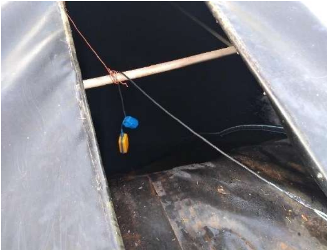
Figura 91: Área de inspeção da Cisterna CF2, com presença de boia para controle de nível
