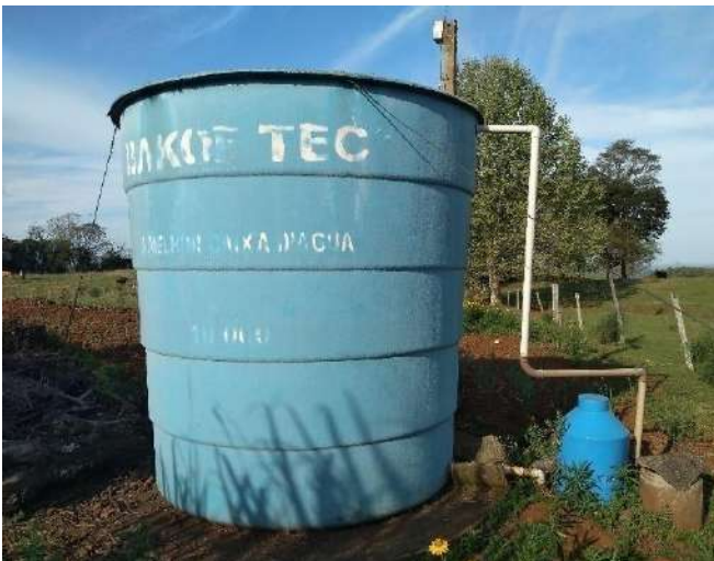
Figura 176: Vista geral do Reservatório R22, com estrutura para a cloração da água
