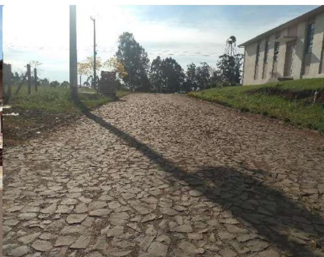
Figura 9: Arruamento de paralelepípedo presente na comunidade Cerro do Meio Dia
