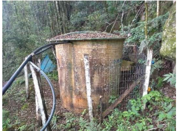
Figura 88: Reservatório RF2, com cercamento
