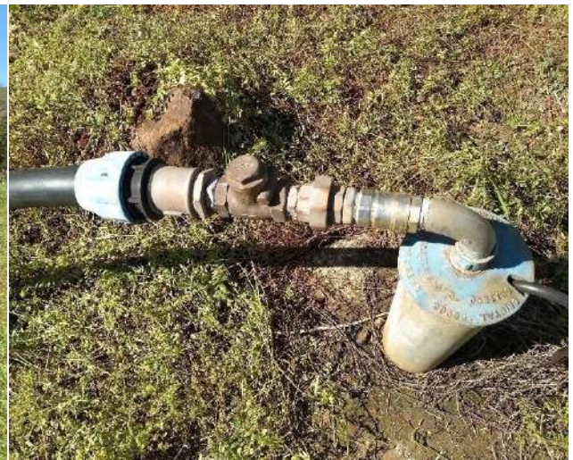
Figura 124: Poço tubular P12, com laje de proteção
