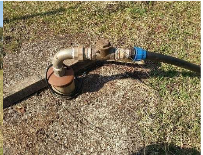
Figura 140: Poço tubular P15, com presença de laje de proteção
