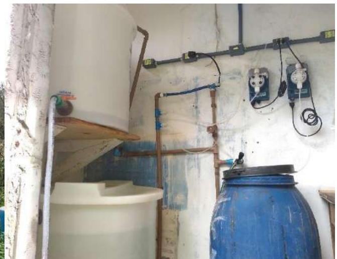
Figura 44: Processo de cloração e fluoretação da água do PC2
