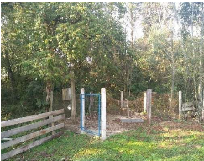
Figura 72: Vista geral do Poço tubular P4, com cercamento e controle de acesso
