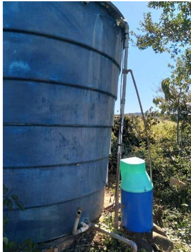
Figura 121: Reservatório R11, nos arredores de uma área agrícola
