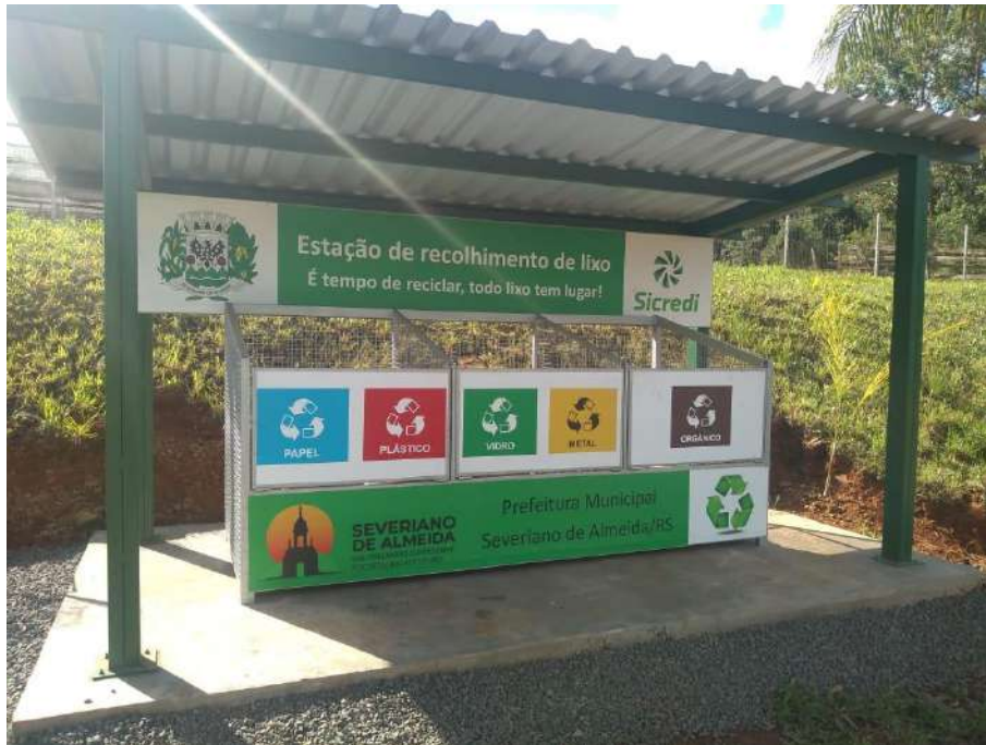
Figura 223: Ponto de disposição e recolhimento de resíduos recicláveis e orgânicos
