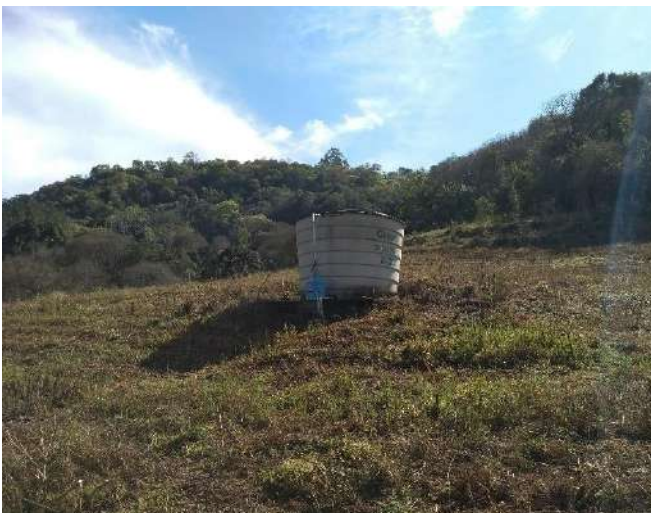
Figura 64: Vista geral do Reservatório R2, alocado em uma área de uso agrícola
