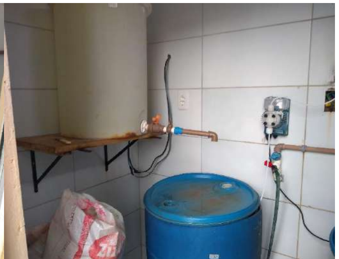
Figura 50: Sistema de tratamento da água e armazenamento de soluções
