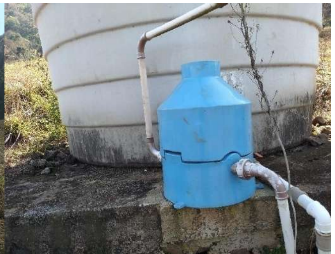
Figura 65: Reservatório 02, com destaque para laje de apoio e estrutura de cloração
