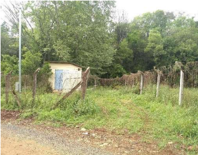
Figura 41: Vista geral do poço tubular PC2, com cercamento comprometido
