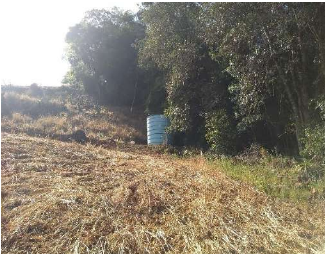
Figura 55: Vista geral do Reservatório R1, alocado próximo a uma área agrícola
