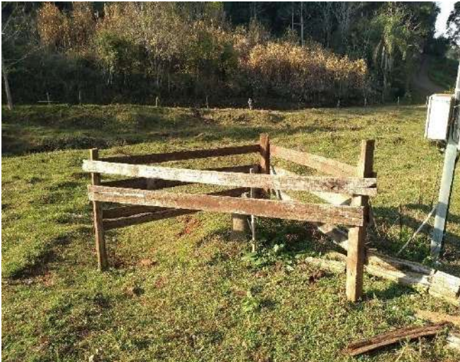
Figura 106: Vista geral do Poço tubular P8, com estrutura de cercamento
