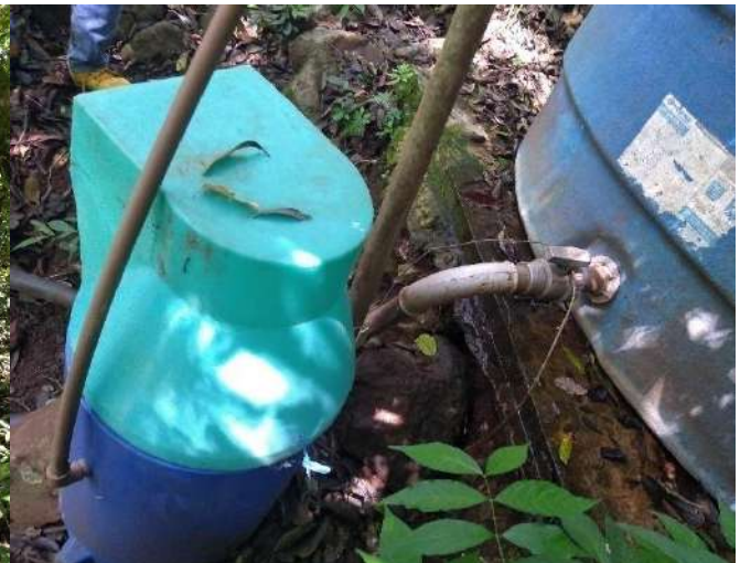
Figura 104: Reservatório R7, com destaque para estrutura de cloração
