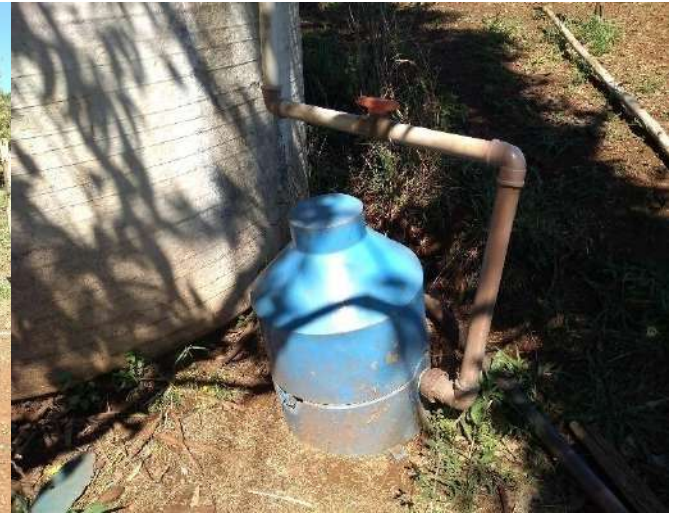
Figura 131: Reservatório R13, destaque para a estrutura de cloração
