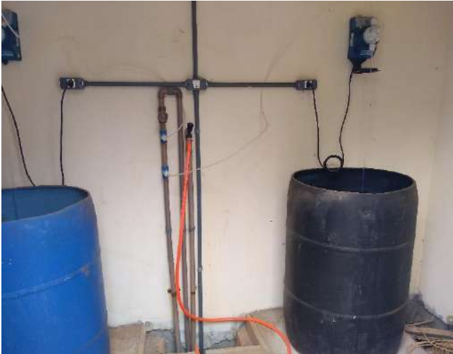
Figura 47: Sistema de armazenamento e bombeamento das soluções de tratamento
