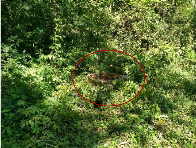
Figura 164: Vista geral do Poço tubular P20, próximo a um fragmento florestal
