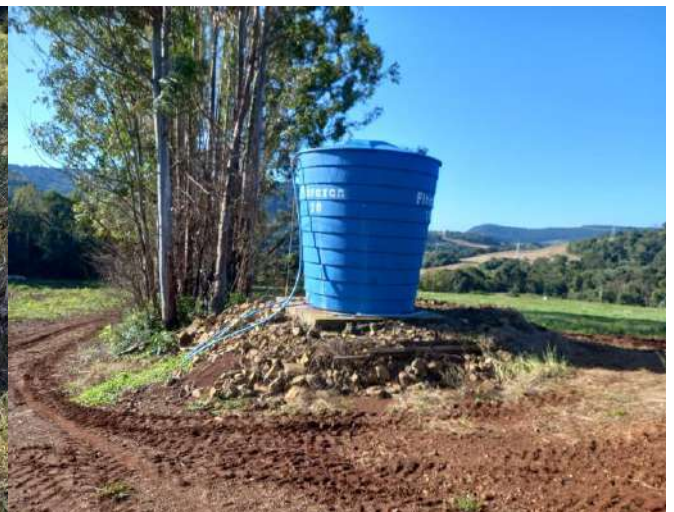
Figura 194: Vista geral do Reservatório R25
