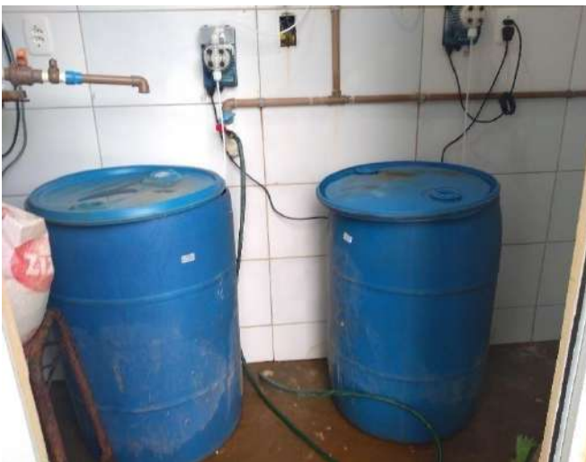
Figura 50: Sistema de tratamento da água e armazenamento de soluções
