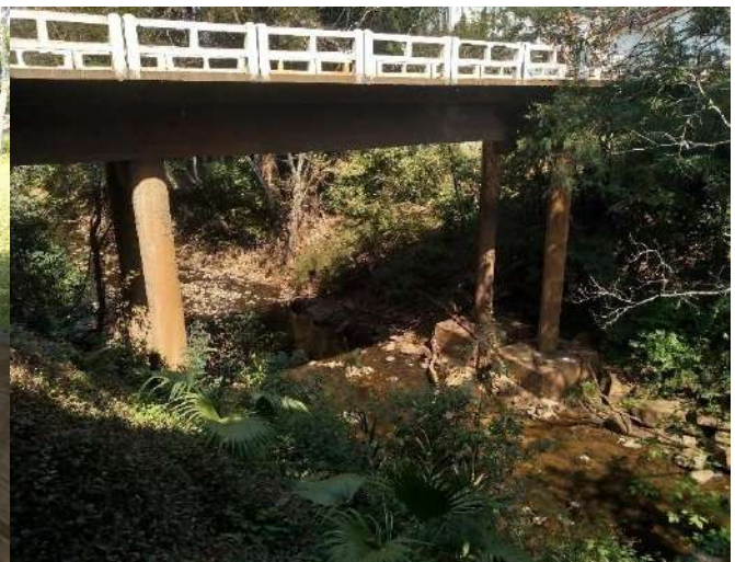
Figura 236: Ponte construída sobre o rio Lamedor
