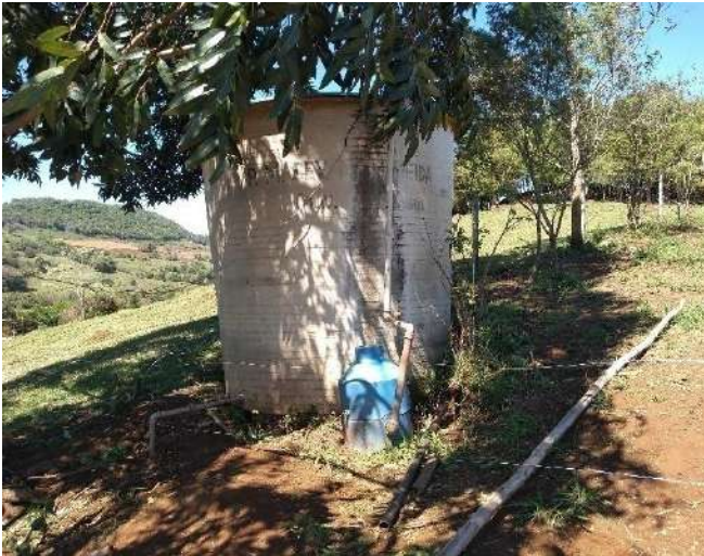
Figura 130: Vista geral do Reservatório R13, com cercamento
