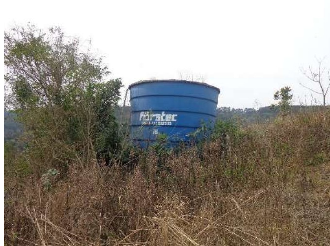
Figura 148: Vista geral do Reservatório R16, alocado próximo a uma área de produção agrícola
