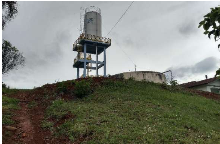
Figura 51: Vista dos reservatórios Rcs1 e Rcs2
