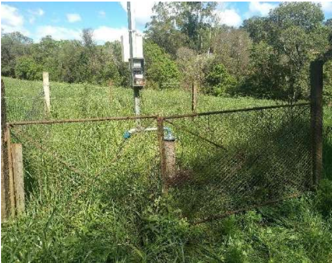
Figura 111: Vista geral do Poço tubular P9, no entorno de uma área agrícola
