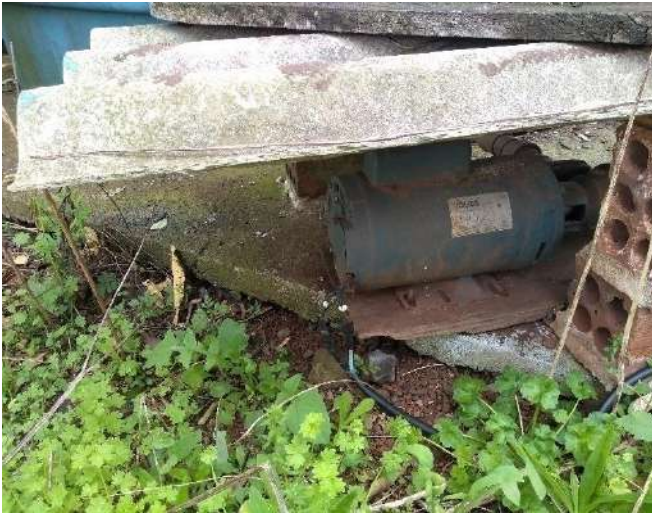
Figura 190: Reservatório recalque Rq24, com presença de bomba para o recalque da água
