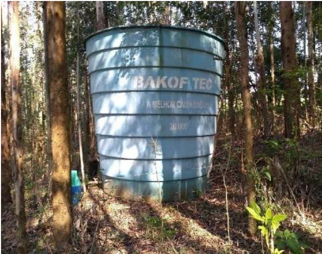
Figura 208: Vista geral do Reservatório R28, próximo a uma área de cultivo de eucaliptos
