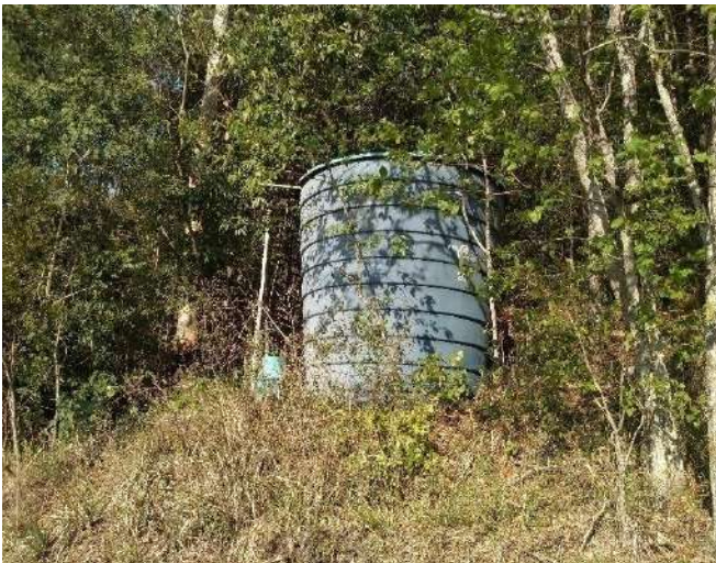
Figura 157: Vista geral do Reservatório R18, próximo a uma área agrícola e de plantio de pinus
