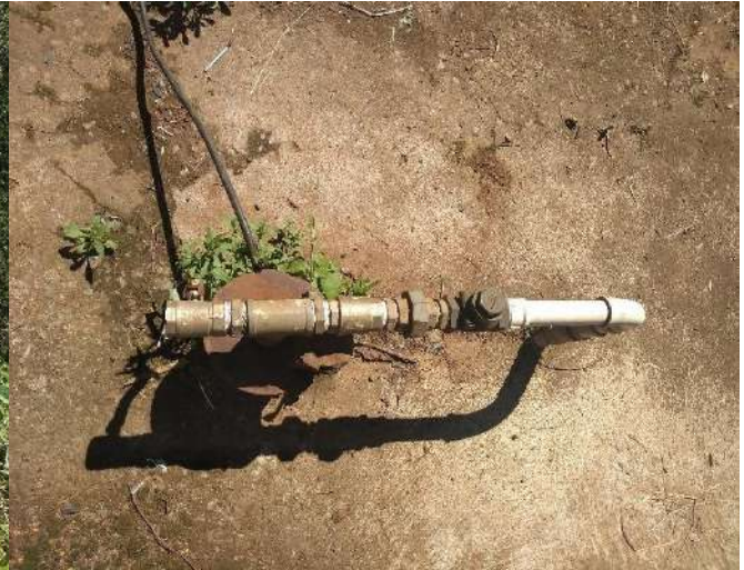
Figura 161: Poço tubular P19, com a presença de laje de proteção
