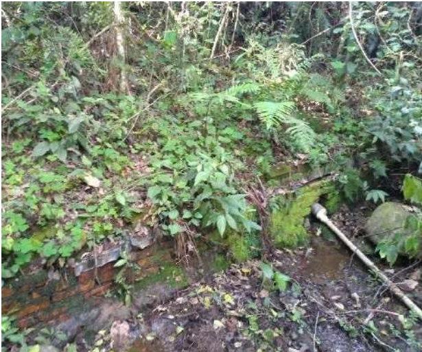
Figura 87: Fonte drenada F2, construída com base no método Caxambu
