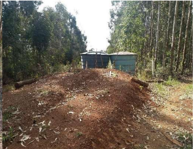
Figura 97: Reservatório RrF3, com acesso o abastecimento por meio de caminhão pipa
