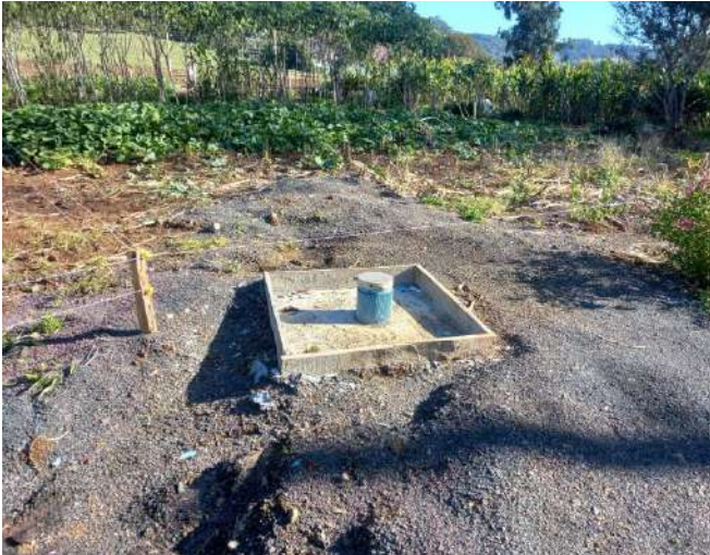
Figura 196: Vista geral do Poço tubular P26, em processo de implantação das estruturas de captação
