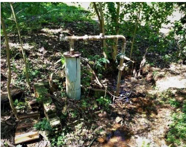
Figura 128: Vista geral do Poço tubular P13, com presença de afloramento de água
