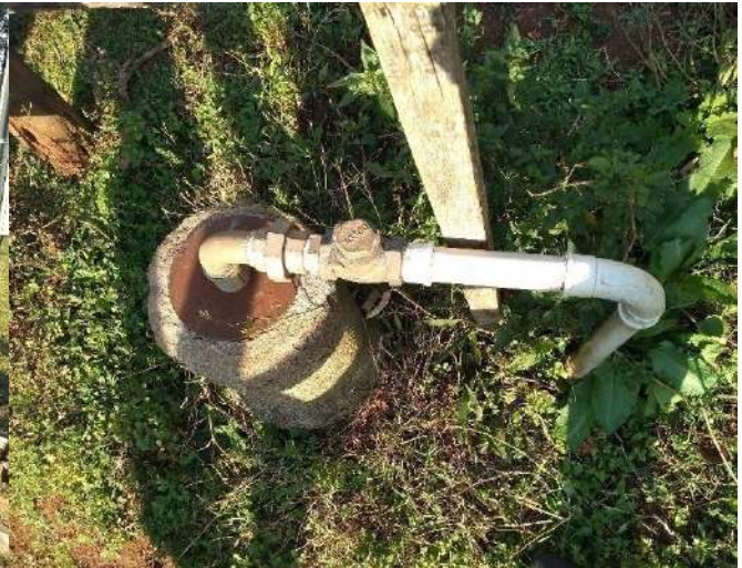
Figura 107: Poço tubular P8, com tubo de concreto concêntrico à tubulação do poço
