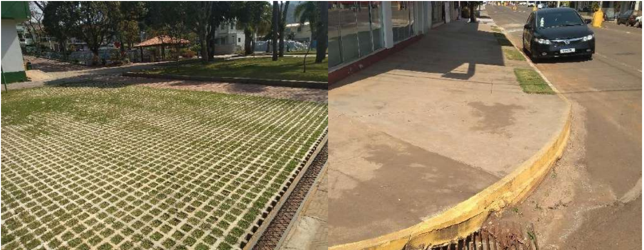
Figura 240: Praça central de Severiano de Almeida com a presença arborização e pavimentação permeável
