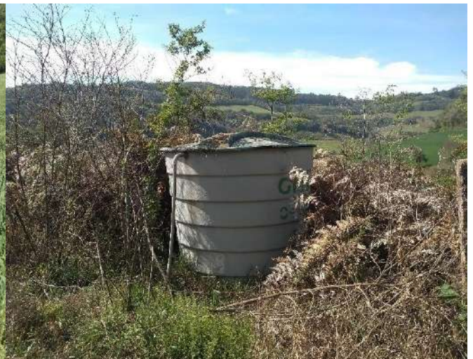
Figura 70: Reservatório R3, sem a presença de estrutura de cloração
