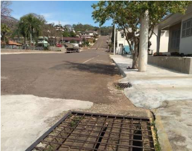
Figura 233: Sistema de drenagem com presença de grades para o escoamento da água pluvial
